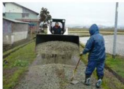
砂利の敷き均し
