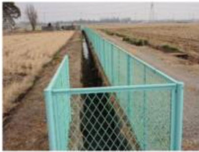
新たに設置された 金網フェンス
