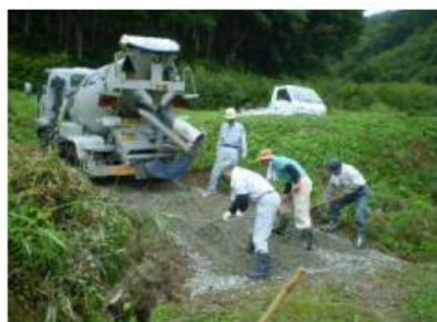
コンクリート舗装状況
