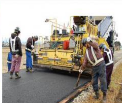
アスファルト舗装状況
