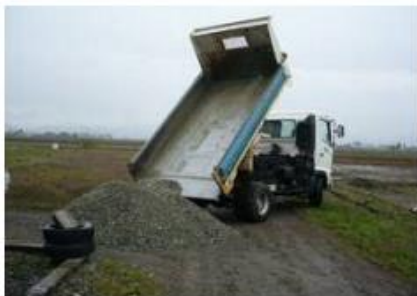
砂利の荷下ろし
