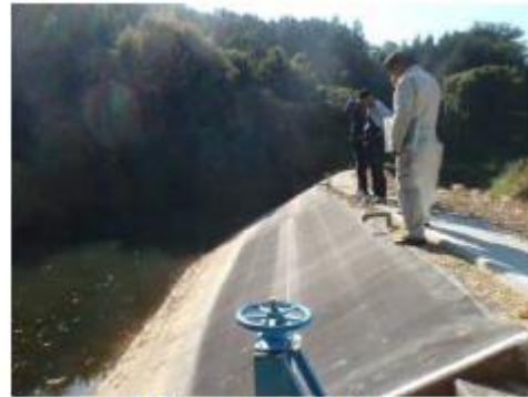
遮水シートの設置
