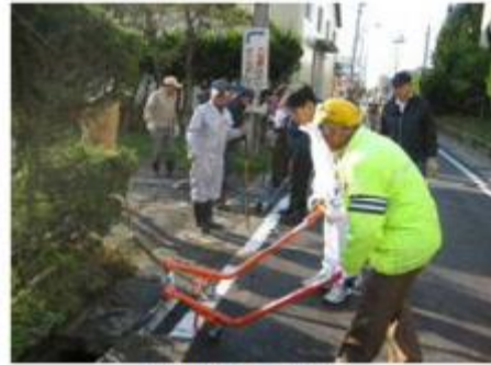
水路蓋の設置 (専用器具使用)
