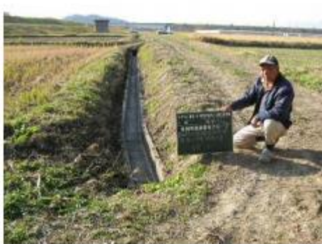
土側溝をコンクリート側溝に更新
