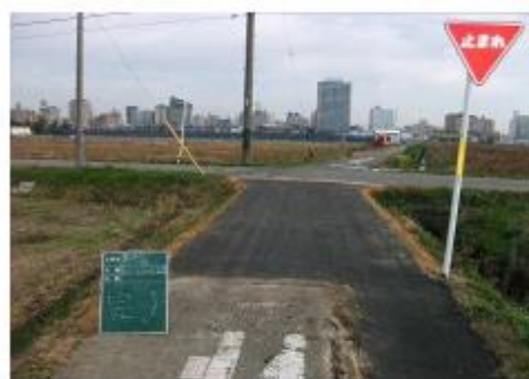
アスファルト舗装の打換え
