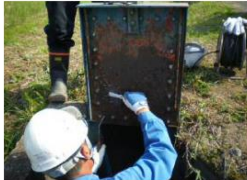
ゲートの補修状況
