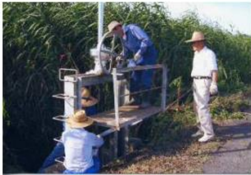
ゲートの点検
