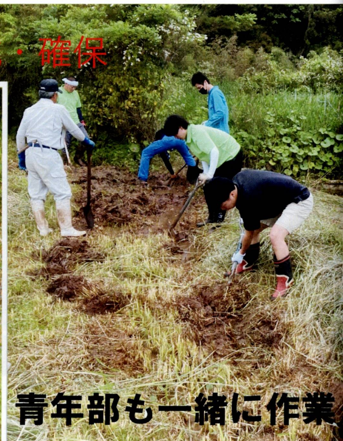
イノシシ柵設置
